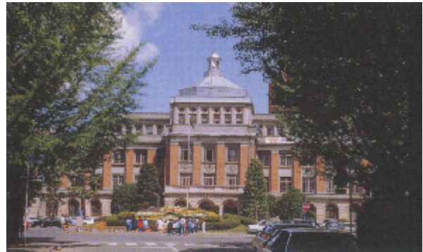
前の宮城県庁の建物は1931年(昭和6年)に完成し、半世紀以上にわたって使われましたが、老朽化と地震による被害などがあり、1986年(昭和61年)に解体されました。
